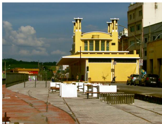
FIGURA 3 - Depois da requalificação
