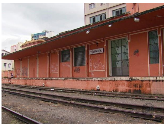
FIGURA 2 - Antes da requalificação
