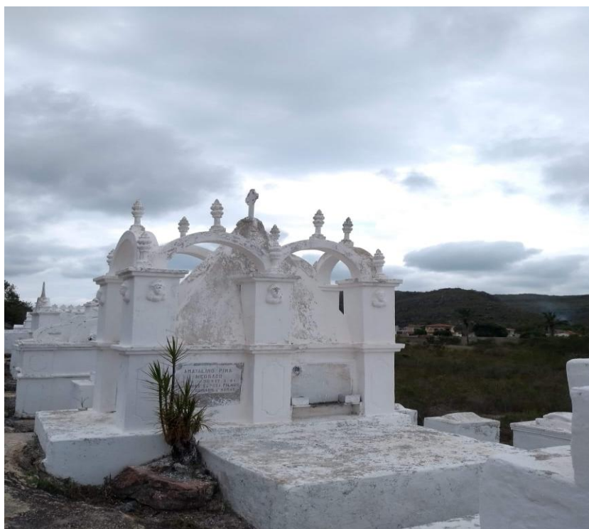
Figura 11 – Arquitetura do Cemitério Bizantino.
