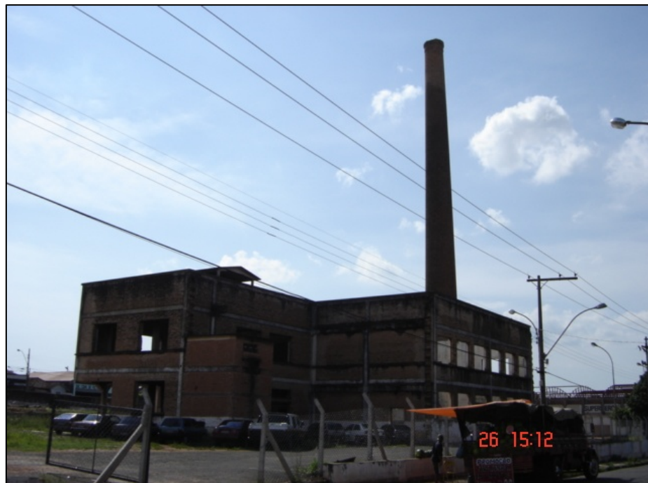
Figura 2: Vista geral da casa das caldeiras e chaminé, antes da reforma, em 2005, e nessa fotografia é possível observar o antigo uso do imóvel, um estacionamento de veículos, sem nenhuma estrutura, em estado de ruínas e abandonado. Autor: Rodrigo Modesto Nascimento, 2005.
